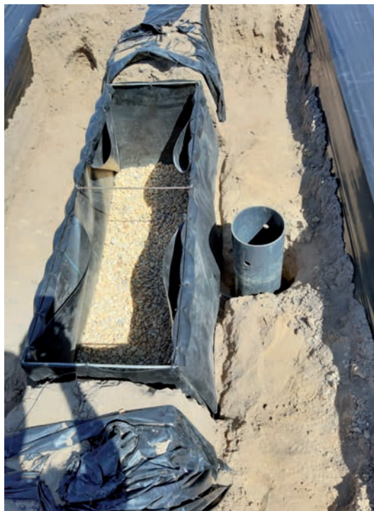
Instalación de lisímetro de drenaje. A la derecha puede observarse el tubo de recogida de drenajes.
